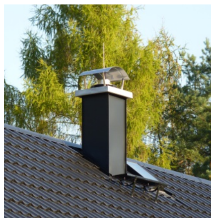
Oplechovaná základ nadstřešní část s oblou stříškou
