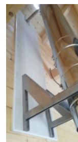
Založení na stěně
