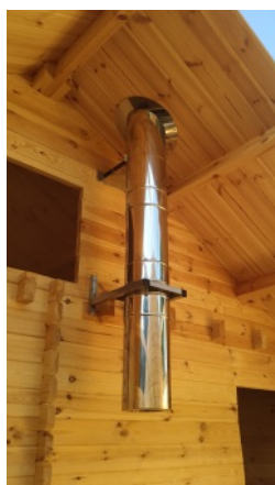
Příklad založení svislého kouřovodu
