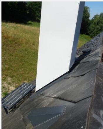
Detail přesazení návleku Štuko přes lemování
