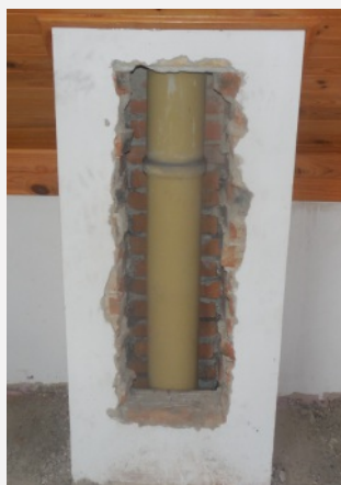
Z realizace vložkování SANATEC
