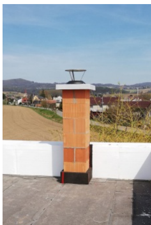
Parotěsný vstup plochou střechou
