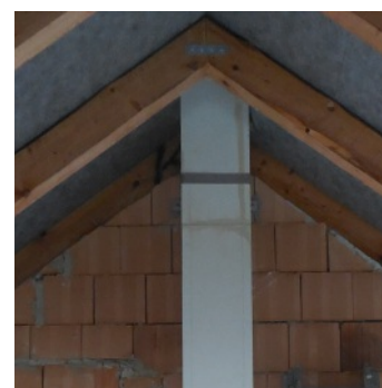
Přiběžné kotvení stěnovým úchyttem
