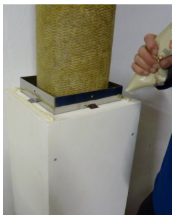
Slepování šachetních dílů COMPACT
