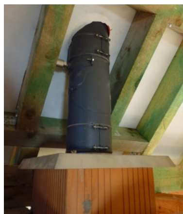
Nerezový nástavec založený pod střešou
