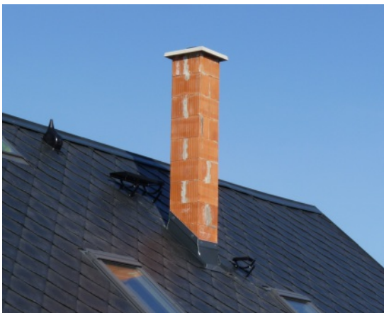
Základní nadstřešní část před finální úpravou
