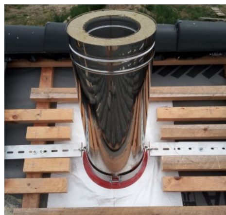
Využití těsnící manžety HotSchott a střešního držáku
