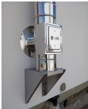
Fasádní komín na konzoli s dvířkovým dílem
