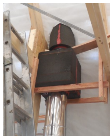
Parotěsné prostupy na nerezovém komíně
