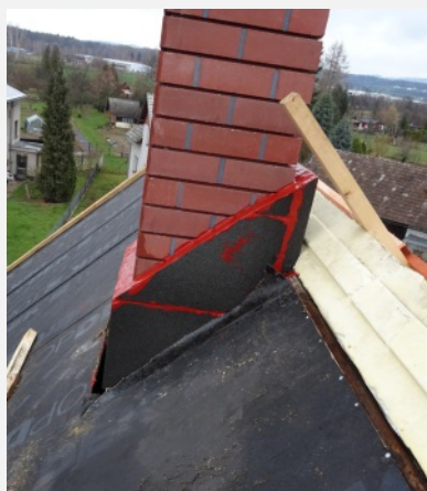
Parotěsný průstup před pokládkou nadkroevní izolace
