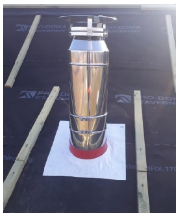
Manžeta HOTSchott nalepená k pojistné hydroizolaci
