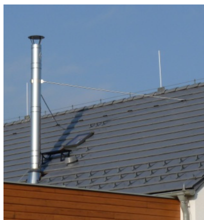
Kotvení komínu pomocí teleskopických tyčí
