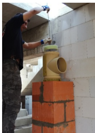
Čištění spojů CIKO TEC
