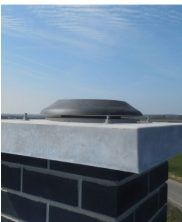
Krycí deska s přívodem vzduchu
