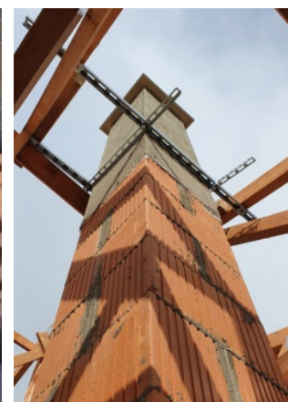
Kotvení komínu CIKO ke krovu
