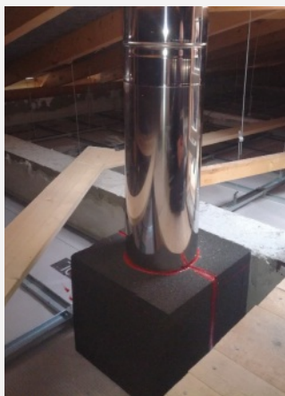
Parotěsný průstup ve stropě
