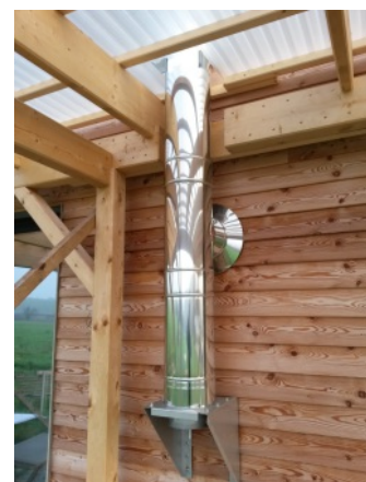
Nerezový komín založený na konzoli
