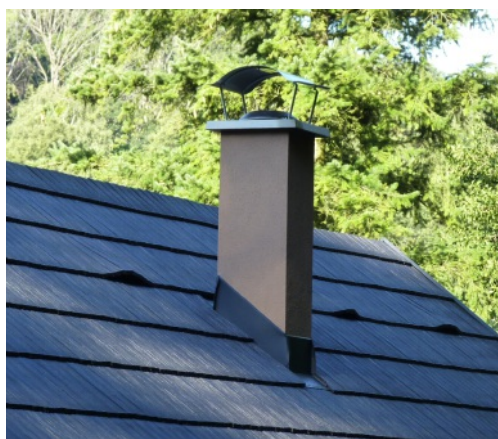
Omítnutý základ s oblou stříškou
