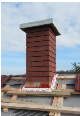
Bezpečný vstup komína střešní konstrukcí
