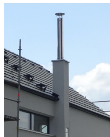
Nerezový nástavec založený nad střešou
