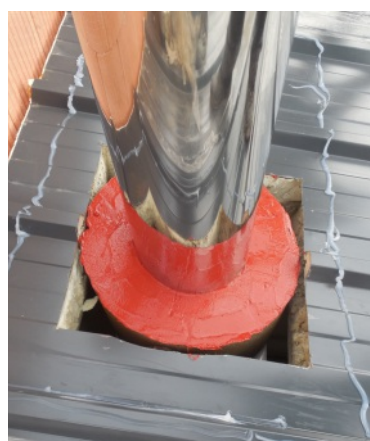
Parotěsný vstup zatřený záruvzdorným silikonem
