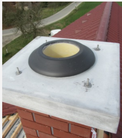
Příšroubovaná krycí deska pro přívod vzduchu
