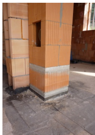
Přerušení tepelného mostu na hrubé podlaže
