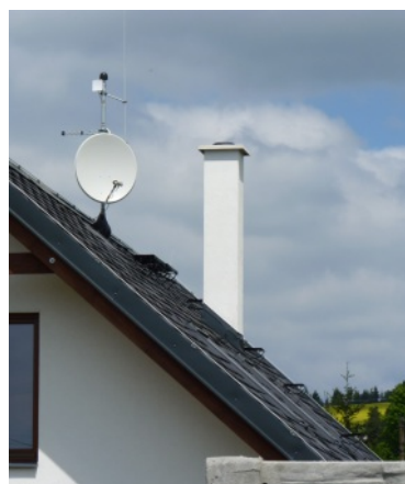
Omítnutá základní nadstřešní část
