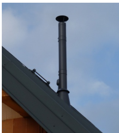
Nerezový komín lakovaný podle odstínu krytiny
