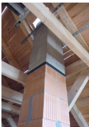
Přerušení tepelného mostu v úrovni stropu
