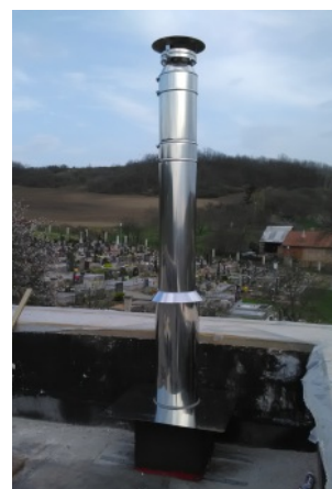
Prostup a vysoké lemování na ploché střeše
