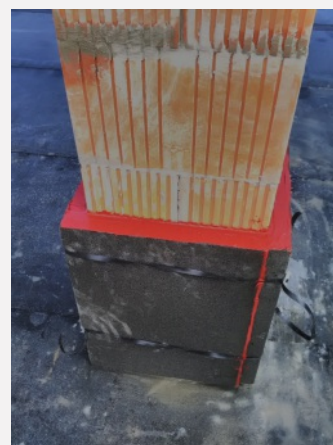
Parotěsný průstup na ploché střeše
