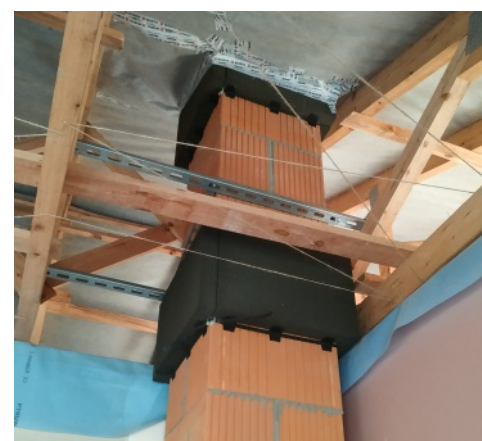
Parotěsné prostupy na cihelném komíně
