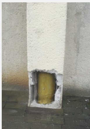
Z realizace vložkování SANATEC s izolací
