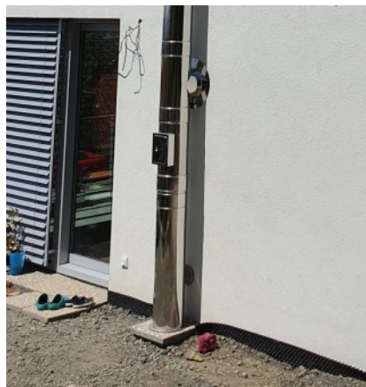
Komín založený na krátkitelném podstavci
