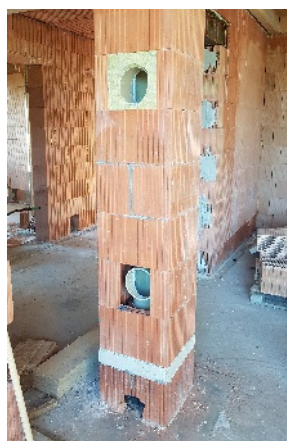
Příprava na přívod vzduchu podlahou
