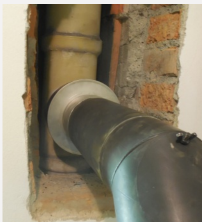
Nápojení kouřovodu redukcí na izostatické vložky
