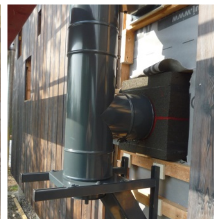
Parotěsný vstup kouřovodu
