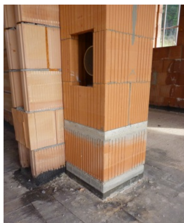
Přerušení tepelného mostu pod komínem
