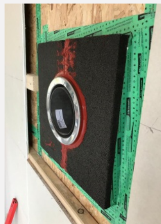
Parotěsný průstup v obvodovém plášti dřevostavby
