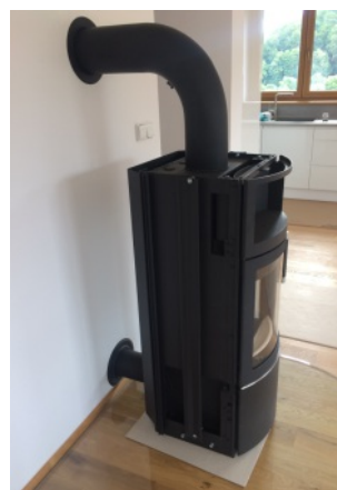
Napojení kamen na přívod vzduchu
