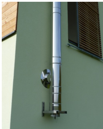
Fasádní komín na konzoli s čištěním spodem
