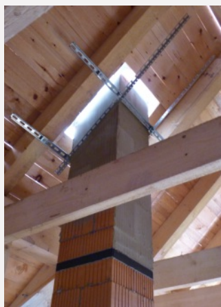
Přerušení tepelného mostu mezi vaznicemi
