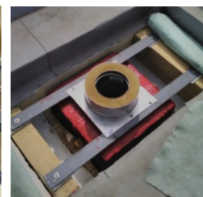
Detail založení v ploché střeše
