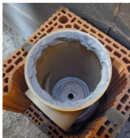
Spárovací hmota v hrdle vložky CIKO TEC
